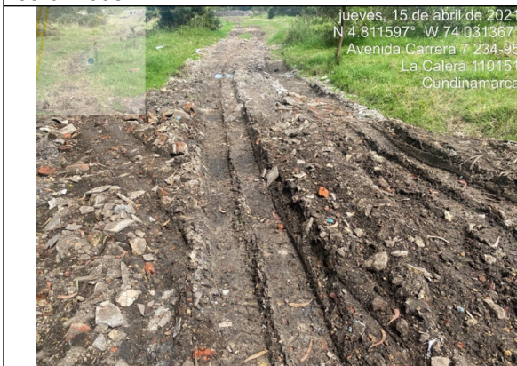
Fotografía 7. Punto de acopio y disposición de Residuos de Construcción y Demolición – RCD mezclados, como cantos, PVC, ladrillos, madera y cerámicos
